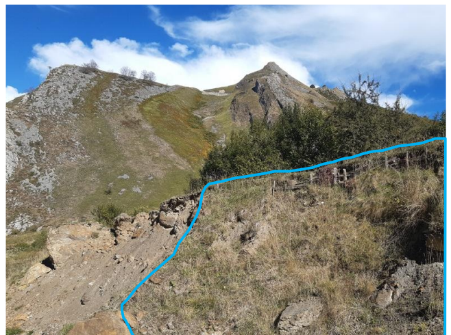
Fig. 22 : A droite, 16 mois plus tard, stabilisation de la pente avec le génie végétal (Dupin, 07/10/25)
