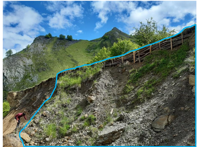
Fig. 20 : A droite, pente avec glissement de terrain ayant fait l'objet d'une intervention en génie végétal avec fascines, plantations et semis (Dupin, 22/05/24)
