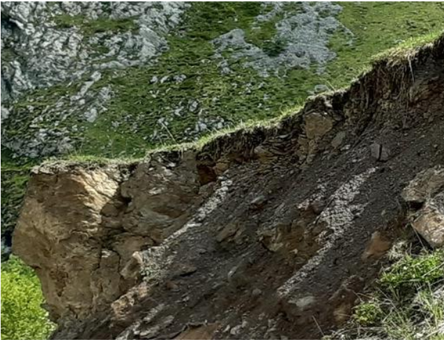
Fig. 19 : A gauche, pente avec glissement de terrain sans intervention en génie végétal, (Dupin, 22/05/24)
