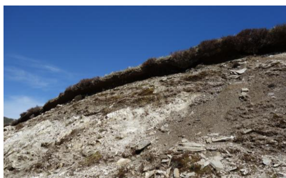
Fig. 2 : Erosion régressive sur talus, Les Crêtes blanches à Béost, (Dupin, 19/05/21)
