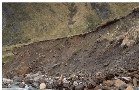
Fig. 1 : Erosion des berges et glissement de terrain au bord de l'Ouzoum à Arbéost, (Dupin, 21/04/22)
