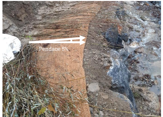
Fig. 5 : Plançons (boutures de saules) et plants d'arbustes installés sur un boudin de terre (Dupin, 04/12/25).
