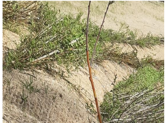
Fig. 6 : Ligne de boutures de saules plaquées entre deux boudins de terre (Dupin, 04/04/2026).
