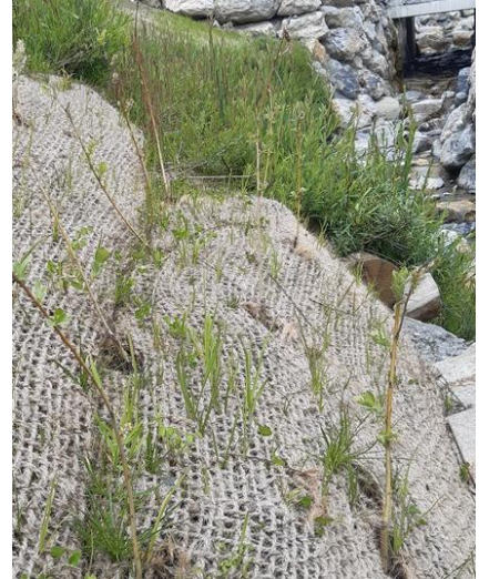
Figure 4 : Boudins plantés avec des plants de saules, (Dupin, 11/05/26)
