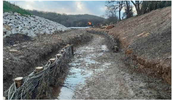
Fig. 7 : Fascine simple de pied de berge (Dinger, 2026).
