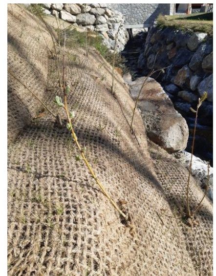
Figure 5 : Boudins plantés avec des plants de saules
