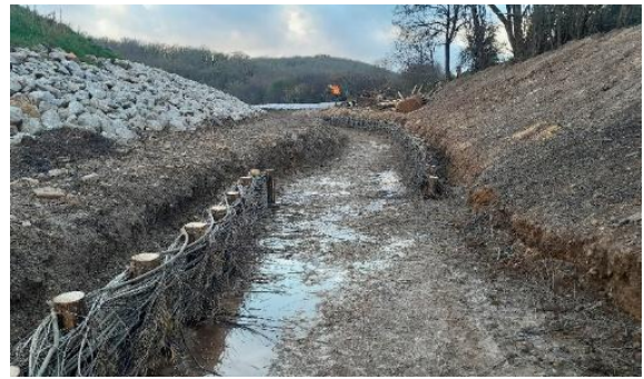
Fig. 8 : Fascine simple de pied de berge (Dinger, 2026).
