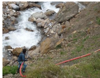
Fig. 1 : Semis à l'hydroseeder (Cazalas, 19/04/21).
