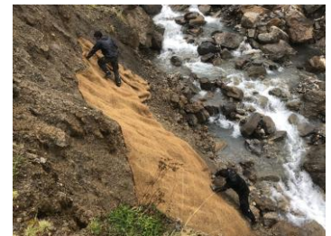
Fig. 2 : Semis sous filet de coco (Roy, 27/05/24)
