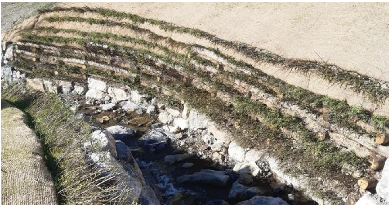
Fig. 18 : Caissons végétalisés sur un socle d'enrochements 4 mois après installation (Dupin, 08/04/26)
