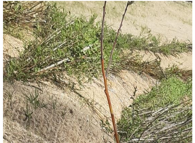
Fig. 7 : Ligne de boutures de saules plaquées entre deux boudins de terre (Dupin, 04/04/2026).
