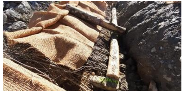
Fig. 14 : Installation de boutures de saules et de boudins de coco entre les longrines avant dépôt de terre et recouvrement avec la toile (Dupin, 04/12/25).
