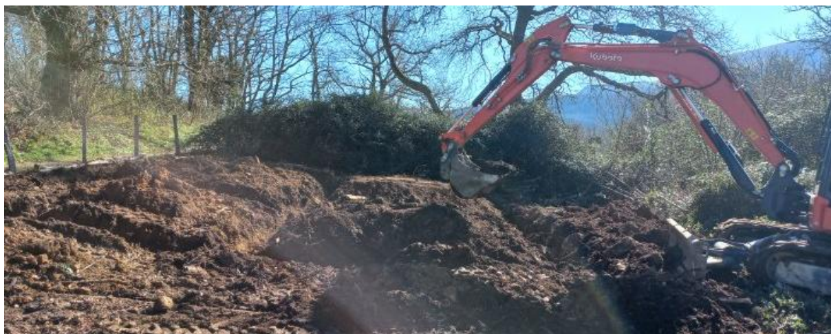
Fig. 6: Profondeur des tranchée (60 cm de profondeur à Cambo les bains (02/02/24).
