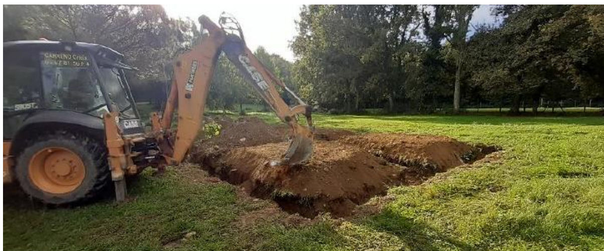
Fig. 3: Préparation des placettes à Séméac avec des tranchées de 60 cm de côté et 60 cm de profondeur (15/09/23)
