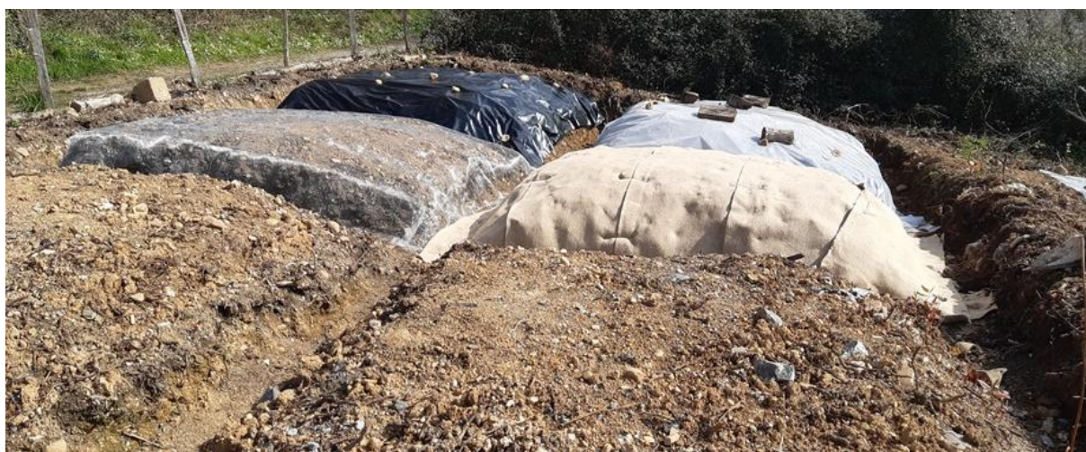
Fig. 7: Profondeur des tranchée (60 cm par rapport à l'enracinement des Renouées du Japon à Cambo (14/03/24).
