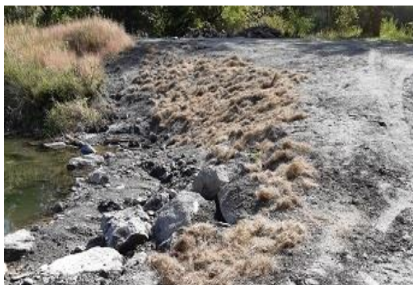
Arrachage de la renouée (12/08/21)
