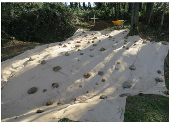
Fig. 5 : Pose du paillage en fibres de chanvre
