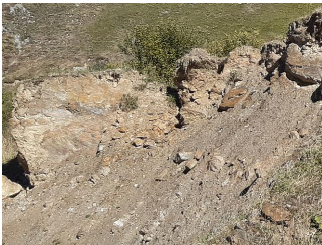
Effet de l'érosion régressive et hydrique 16 mois plus tard (07/10/25)
