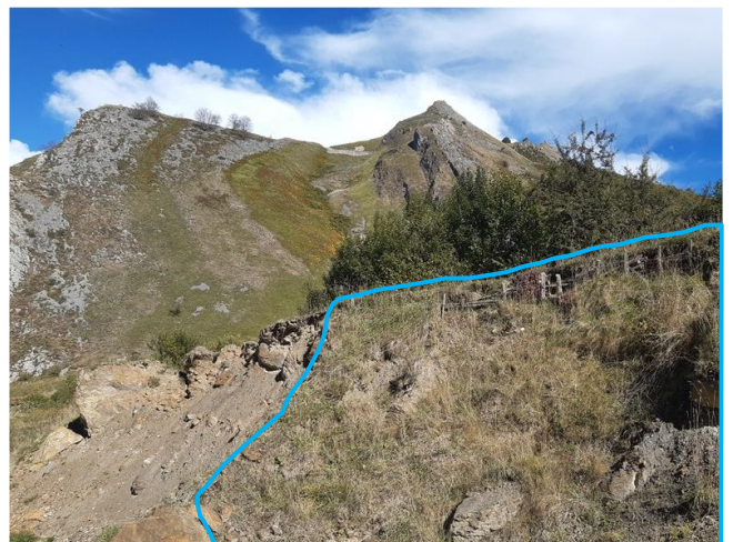
Stabilisation du glissement avec le génie végétal 16 mois plus tard (07/10/25)
