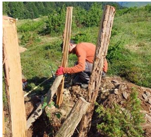
Fixation des piquets sur site caillouteux
