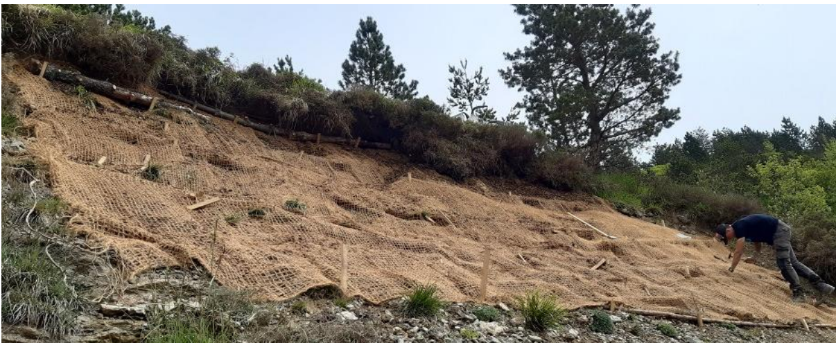
Recouvrement de la zone semée avec du filet de toile de coco (06/06/23)
