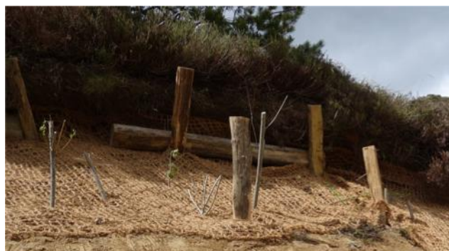
Fixation du haut de l'épaule du talus en utilisant des semences, du foin, des toiles de jute, le tout fixé avec des agrafes, des troncs, des piquets de bois (18/05/21)
