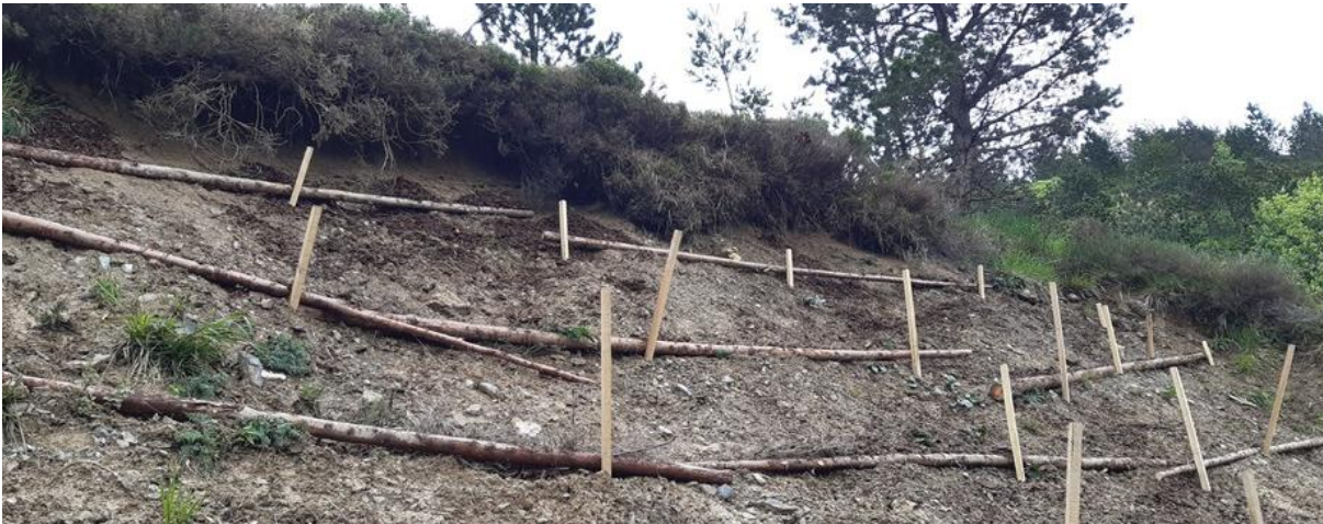
Pause de petites structures en bois pour retenir la terre, les cailloux et les semis (06/06/23)
