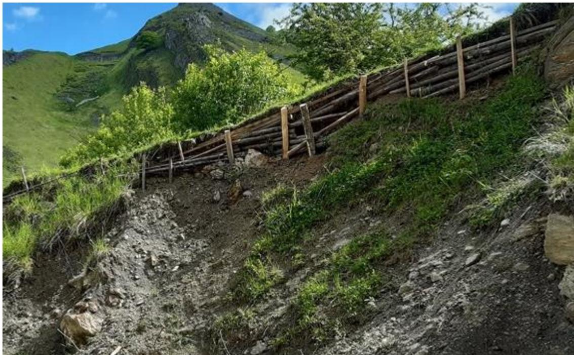
Figure 26 : Stabilisation des bordures instables avec des structures en bois (Arbéost, 07/05/24)
