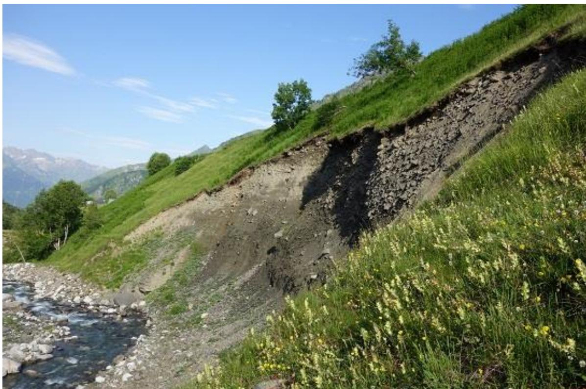
Figure 41 : Glissement de terrain sur la berge du Bastan vu de profil (24/06/2020).
