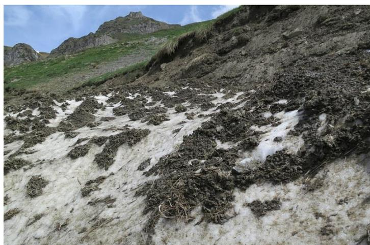
Figure 29 : Erosion par gel et dégel du haut d'un talus routier (16/05/2022)
