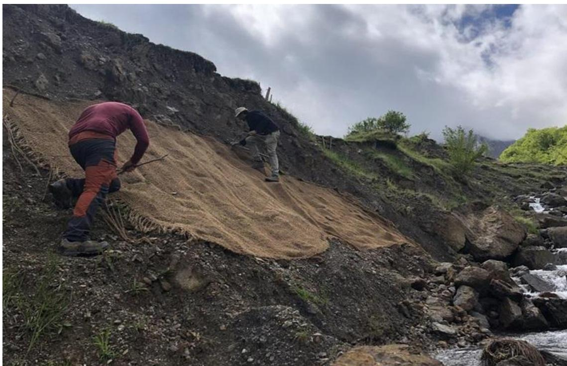
Figure 27 : Semis sous filet de coco pour protéger les substrats sur les parois
