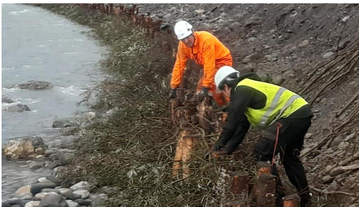
Figure 44 : Installation d'une fascine entre deux rangées de poteaux en pied de berge (Agos-Vidalos, 25/10/2024).
