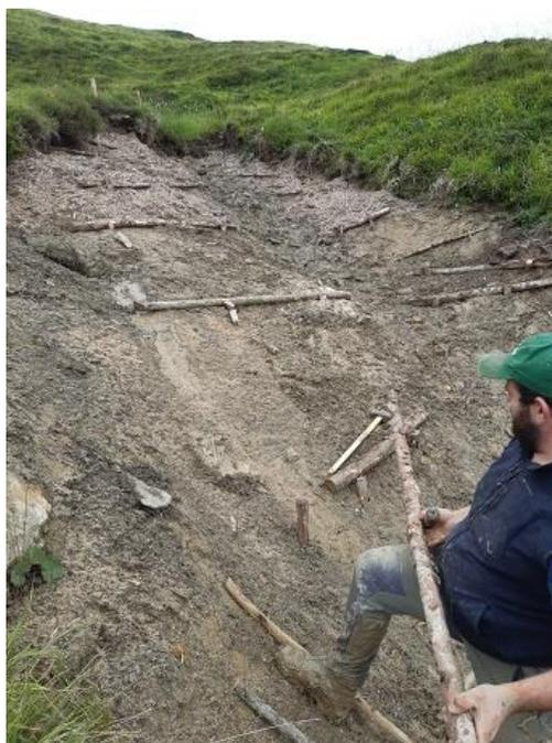
Figure 22 : Installation des structures antiérosives pour stabiliser la surface du substrat (28/06/24).
