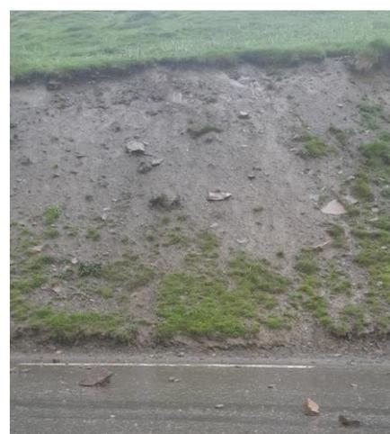
Figure 30 : Erosion hydrique d'un talus routier (13/06/2023)
