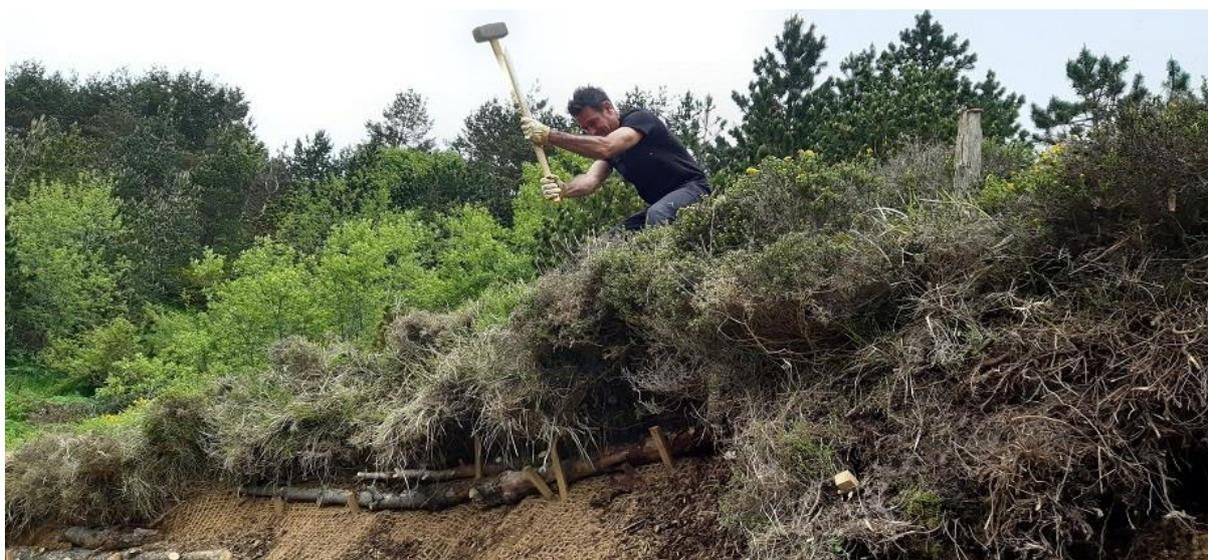
Figure 42 : Fixation de la bordure haute d'un talus à l'aide de piquets d'acacia (Gourette, 06/06/2023).
