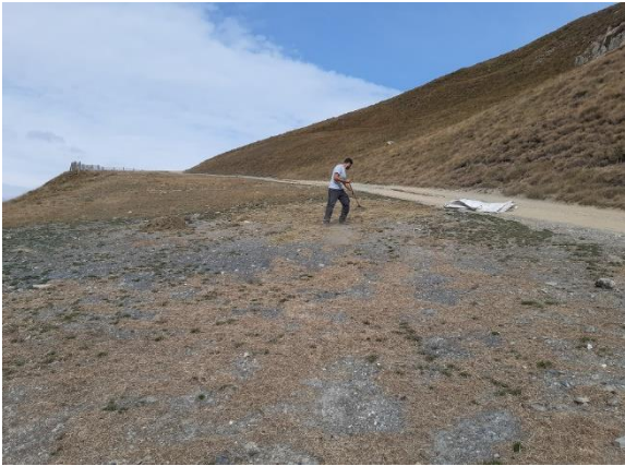
Epandage d'une couche de foin local après grattage du sol et semis (09/09/22)
