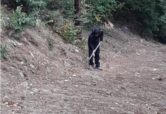
Ratissage du sol sur les plaques lissées par le godet de la pelle (19/10/23)
